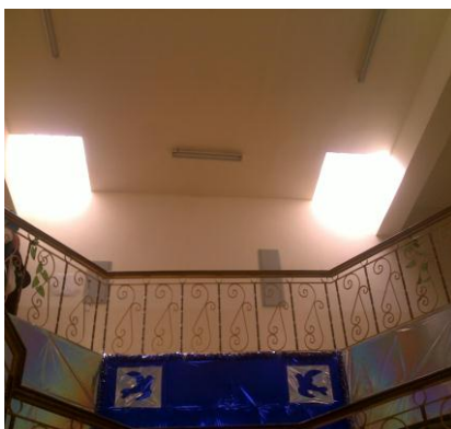
شكل (5) يوضح السقف في بناية الكهرباء
