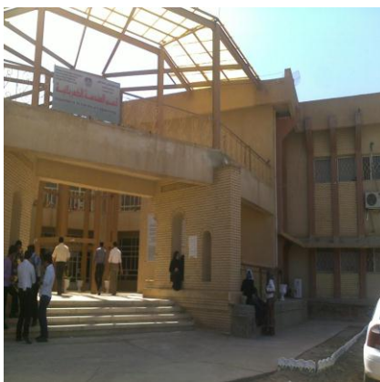
شكل(6) يوضح واجهة بناية الكهرباء
